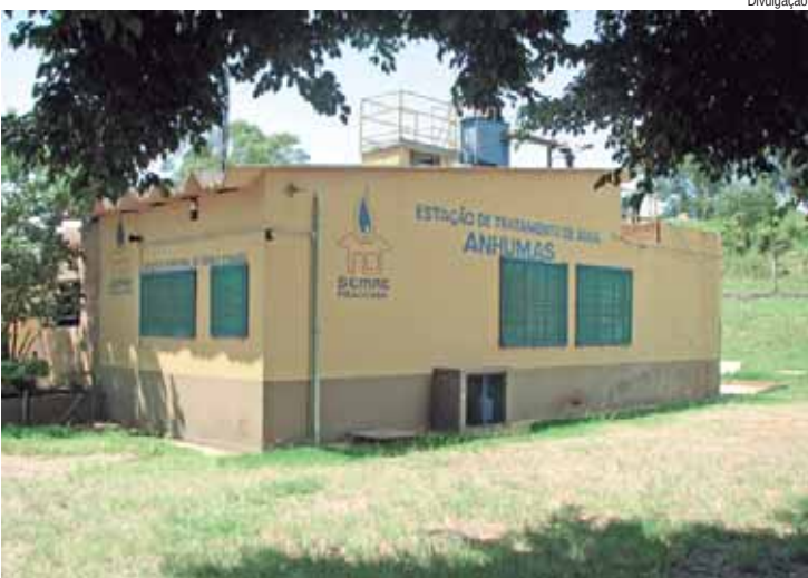
Estação de Tratamento de Lodo será instalada ao lado da ETA Anhumas
