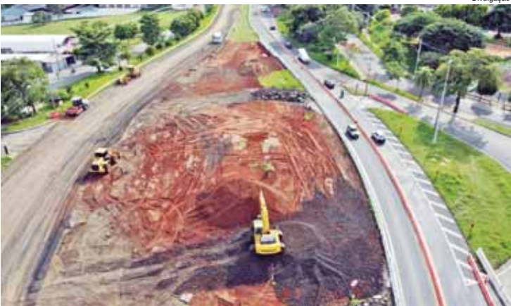
Vista das obras para construção de dispositivo na SP-304
