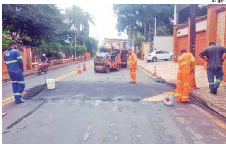
Lombadas foram reinstaladas nas proximidades do condomínio Varandas Campestre, no bairro Campestre
