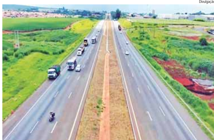
É o primeiro trecho de faixa adicional liberado ao trânsito após início das obras em meados do ano passado
