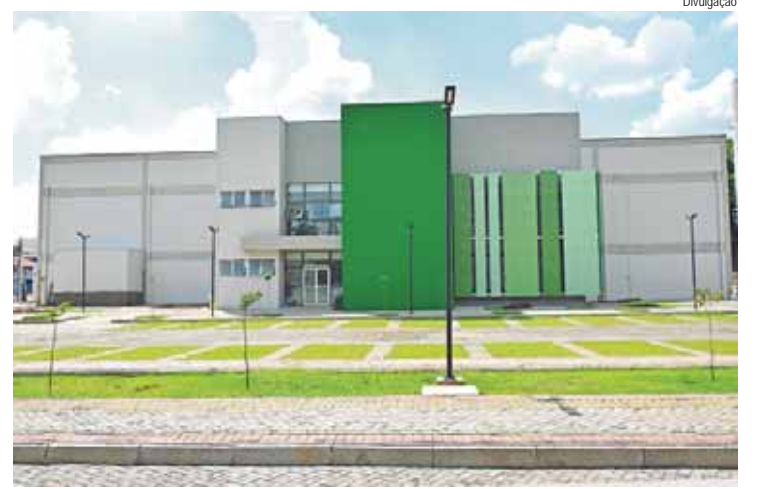
O Centro Clínico Multidisciplinar começou a ser construído em 2009
