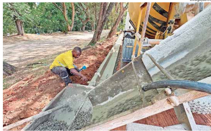
Avenida Sérgio Caldaró está recebendo novas guias e será pavimentada em trecho que ainda não tem asfalto
