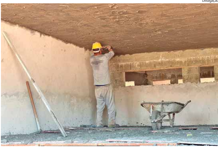
A Secretaria de Obras, Infraestrutura e Serviços Públicos, retomou as obras da Escola Municipal do bairro Nova Iguaçú
