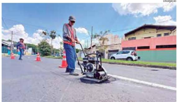
Para facilitar a cobertura de aberturas de pequeno diâmetro no asfalto, equipe utiliza placa vibratória e massa fria
