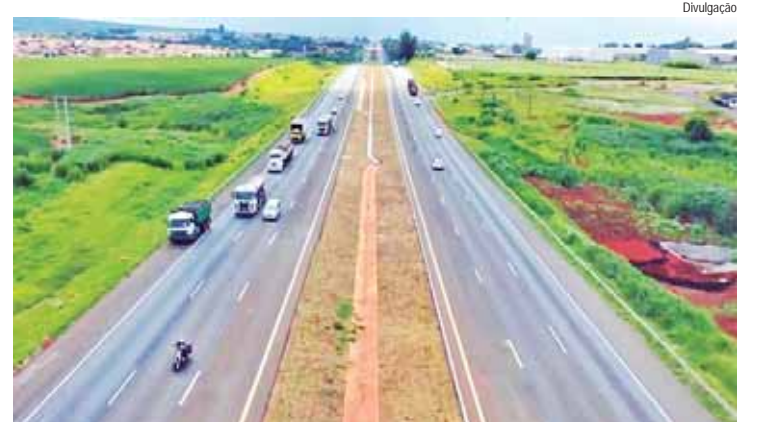
É o primeiro trecho de faixa adicional liberado ao trânsito após início das obras em meados do ano passado
