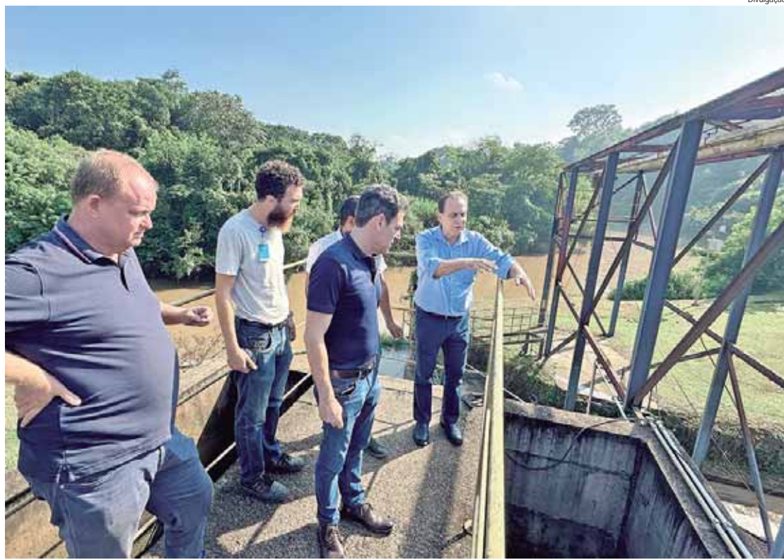
Prefeito Helinho Zanatta durante visita à estação de captação de água, no rio Corumbataí
