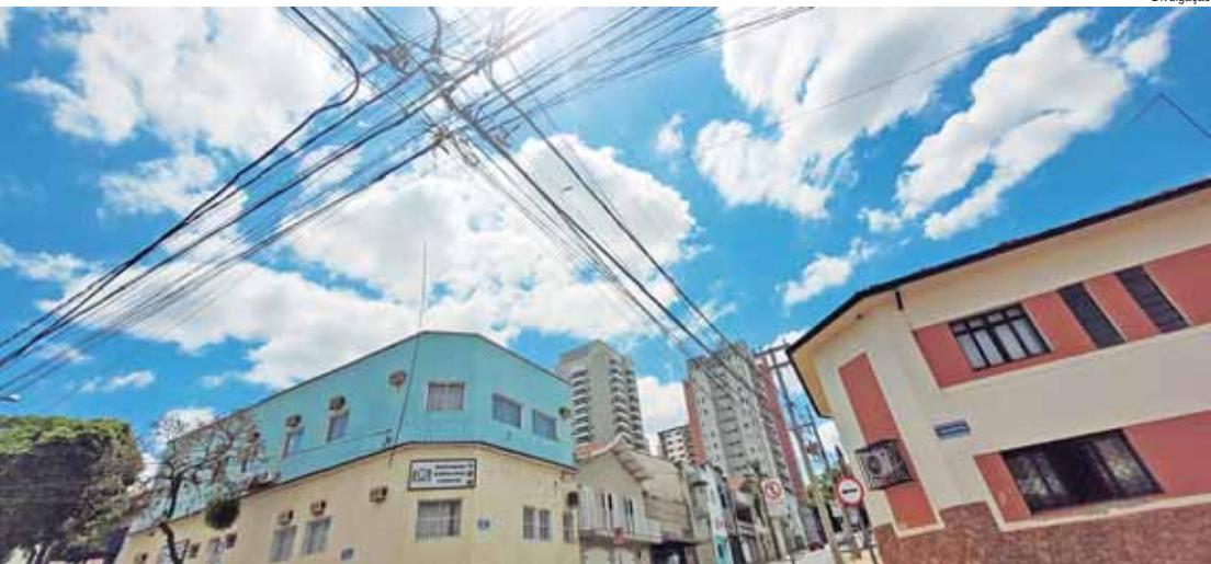
Região central é a que mais concentra problemas com fiação excedente e emaranhados nos postes
