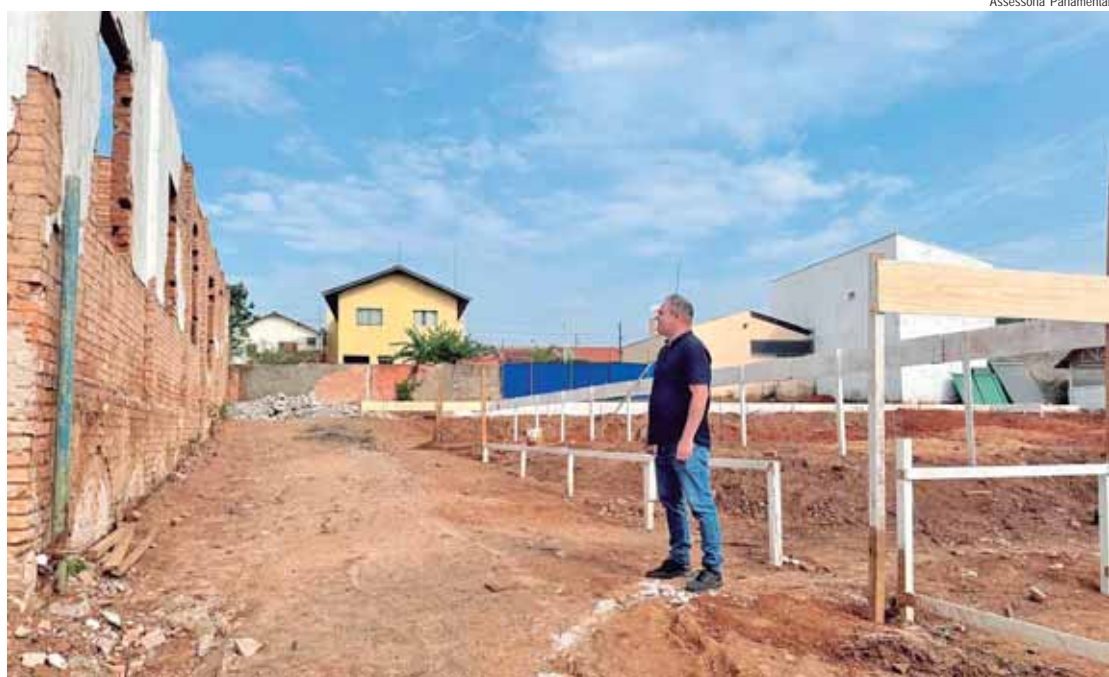
O vereador Josef Borges acompanha as obras de revitalização do Grupão de Artemis e construção de uma nova creche
