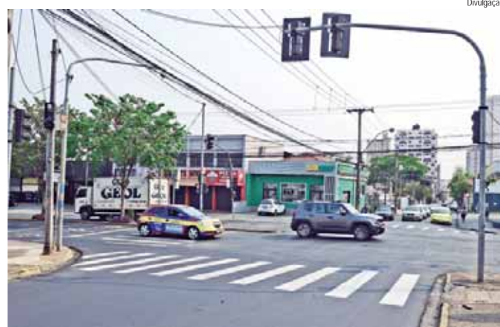
Reforço da sinalização da faixa de pedestre na rua do Rosário
