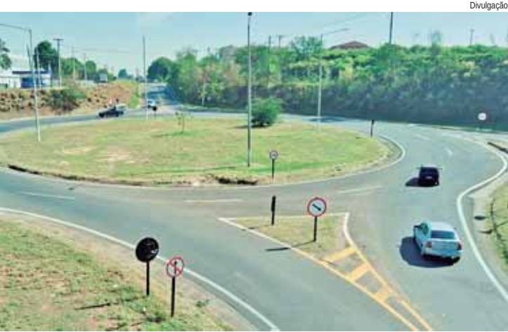
Obras de recuperação do pavimento no dispositivo de retorno, em Monte Mor
