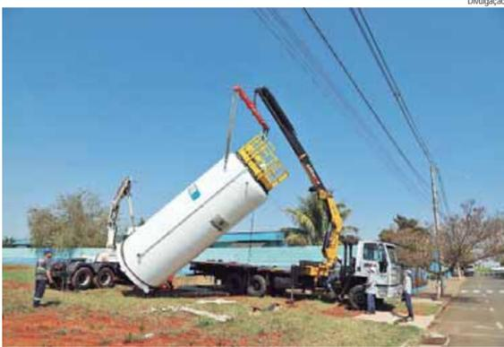
Equipamento foi içado e instalado na base de apoio utilizando um caminhão muncK
