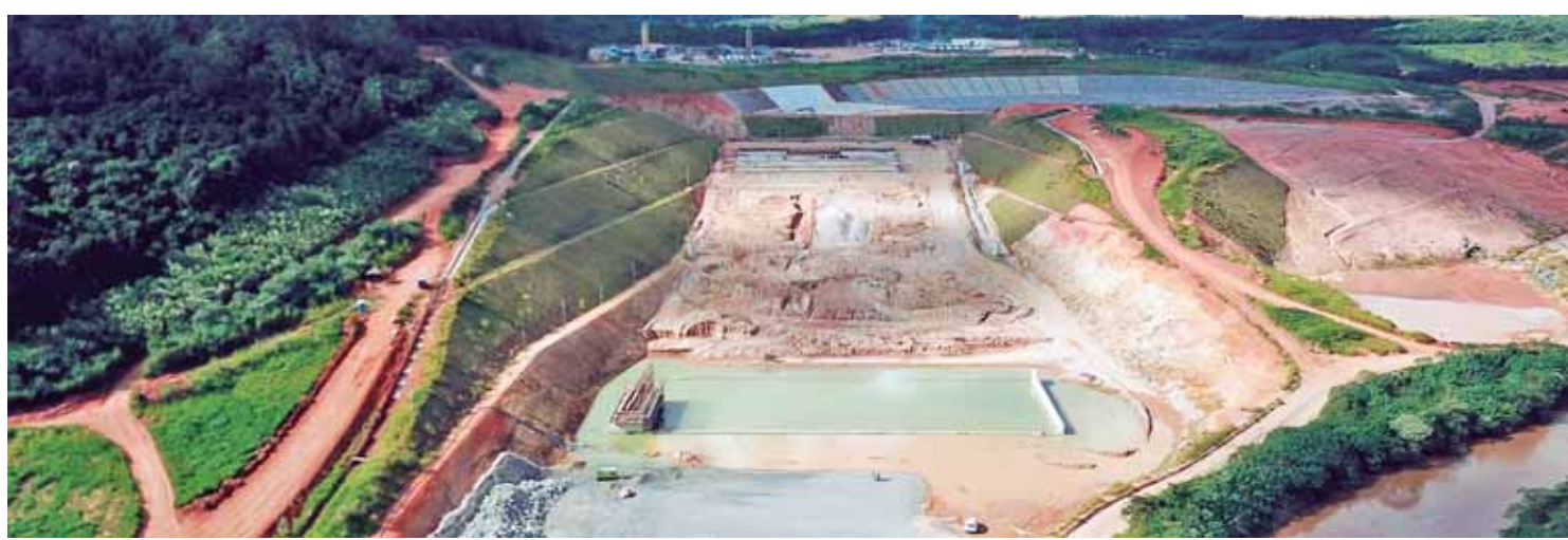
Barragem de Duas Pontes
