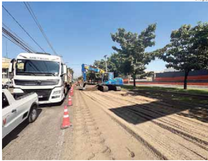
Prefeitura iniciou ontem (26) serviços preparatórios em trecho da avenida Rio Claro
