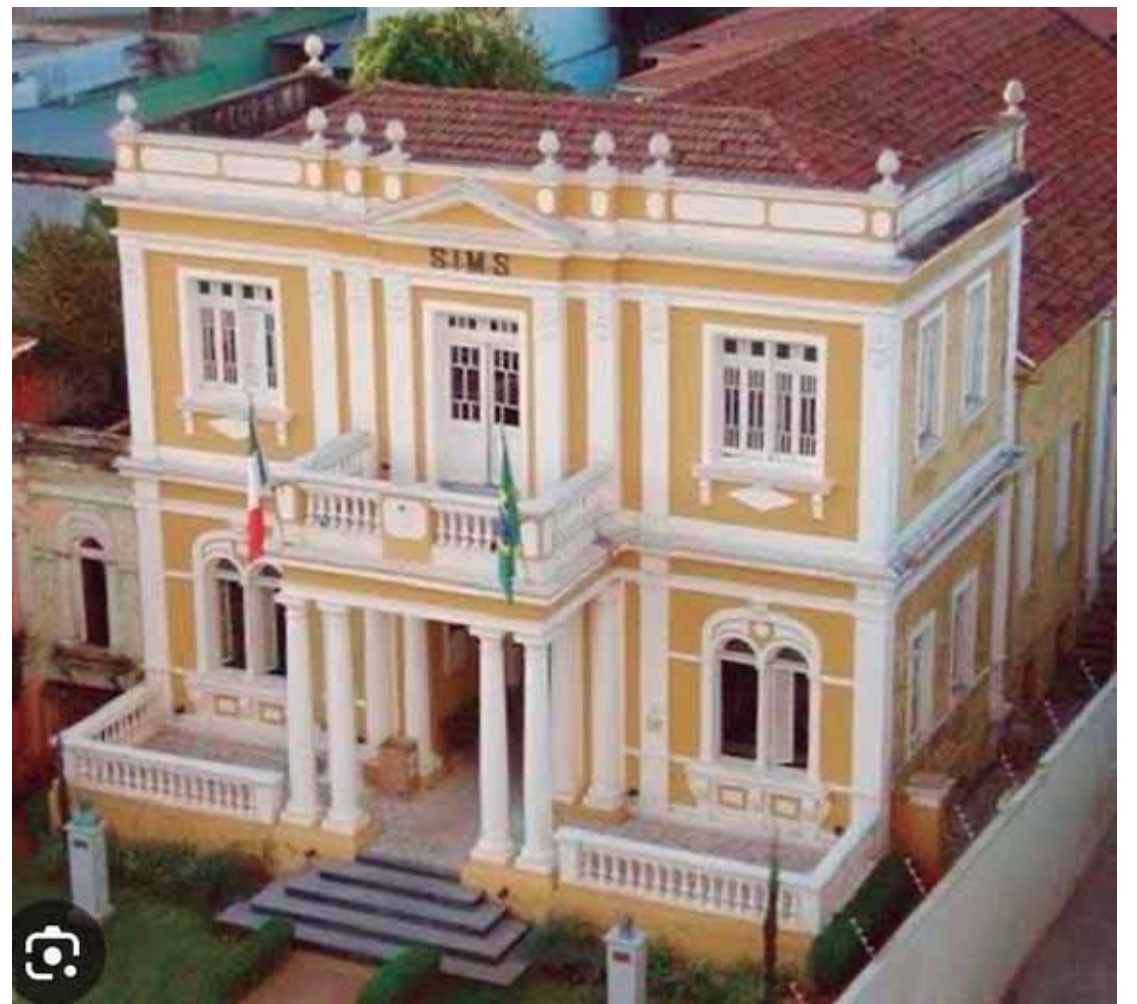
Na rua Dom Pedro I, 781, o prédio construído há 120 anos precisa ser restaurado, com o único teatro no Interior do Estado
