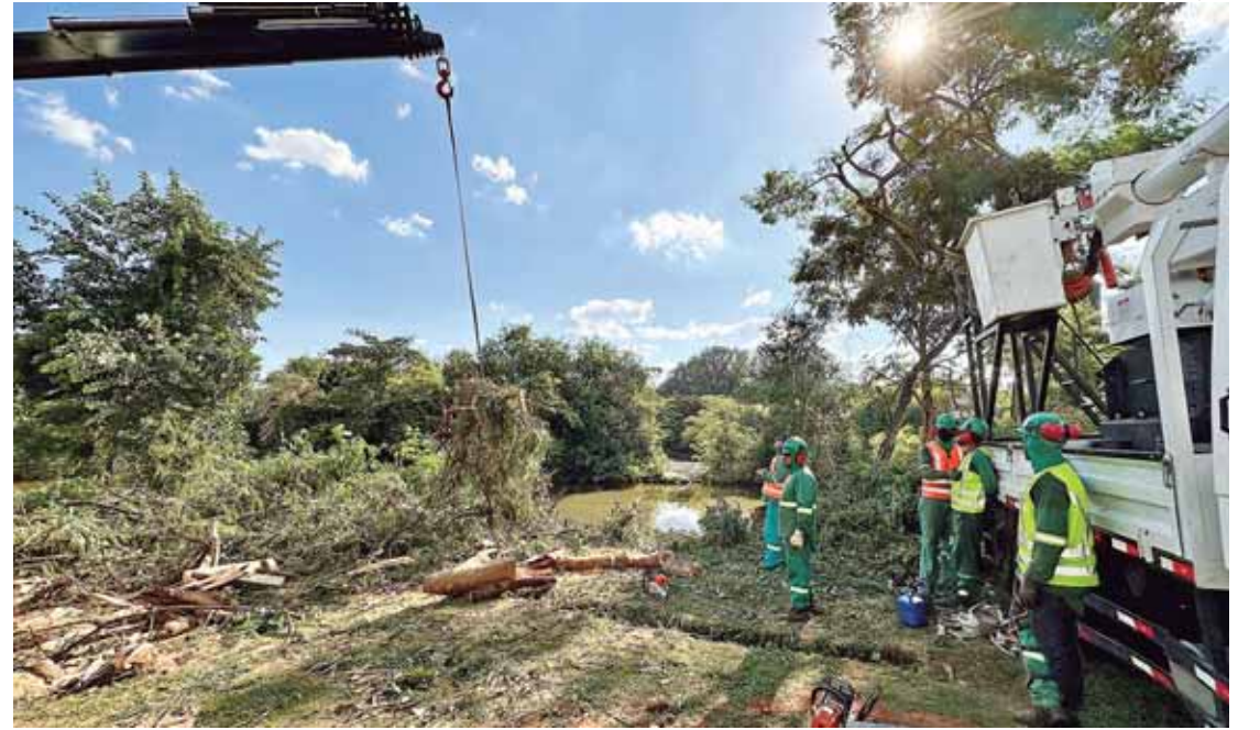
Serviços estão sendo executados na avenida Beira Rio, próximo à Ponte do Mirante
