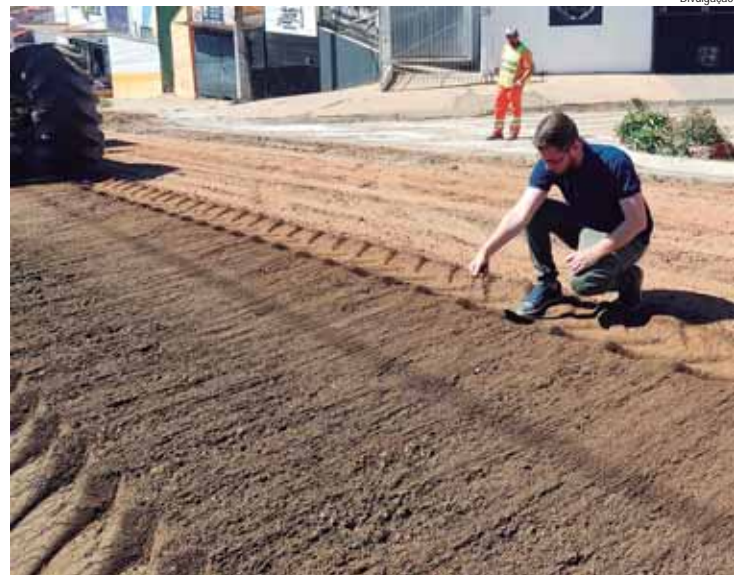
Serviços de recapeamento foram iniciados na avenida Euclides de Figueiredo
