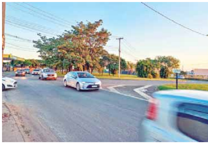
O fluxo de veículos é intenso naquela região e aumenta mais nos horários de pico, havendo a necessidade de intervenção
