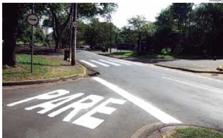
Avenida Alidor Pecorari sinalizada; serviços foram realizados no período de 5 a 10/04
