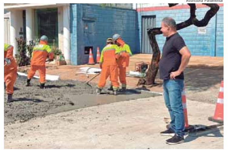
Vereador observa que a pavimentação em concreto deve assegurar maior qualidade e durabilidade na pavimentação desta via pública
