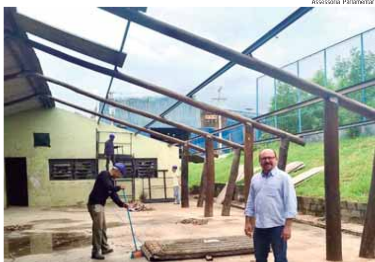
Vereador acompanha reforma do centro comunitário do bairro
