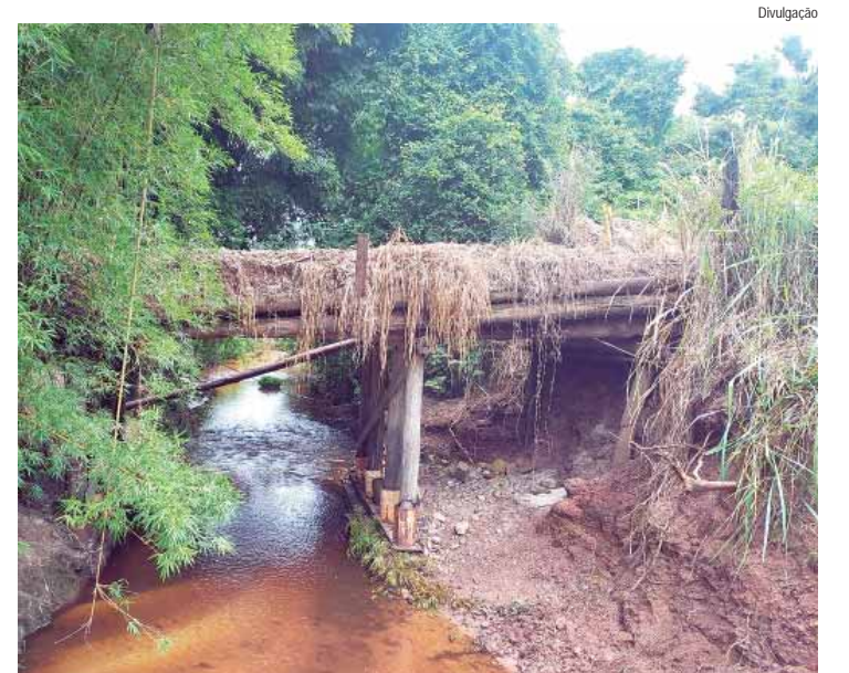
Ponte de madeira no bairro Jiboia será reconstruída pela Sema
