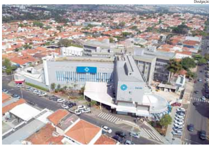
Foto aérea do conjunto hospital do HFC Saúde
