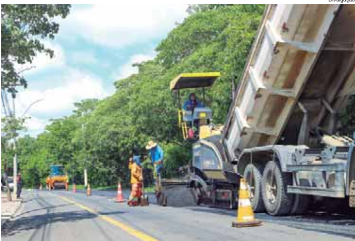
Avenida Abel Pereira vai receber todos os serviços de drenagem necessários, fresagem e recape total da via 5
