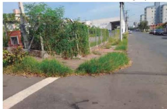
Corte de mato, limpeza, reparo asfáltico e reconstrução de canaletas são necessários para o trecho
