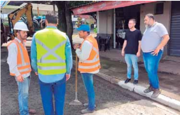
Gustavo Pompeo acompanhou nesta sexta-feira as obras de pavimentação em concreto na avenida 1º de Agosto
