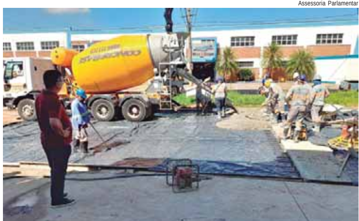
Kawai verifica obra realizada na avenida 1º de agosto, na Vila Rezende
