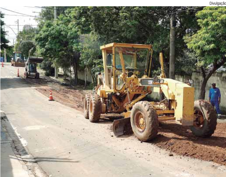
A rua dos Mandis passa agora por adequações no solo, para posterior recapeamento
