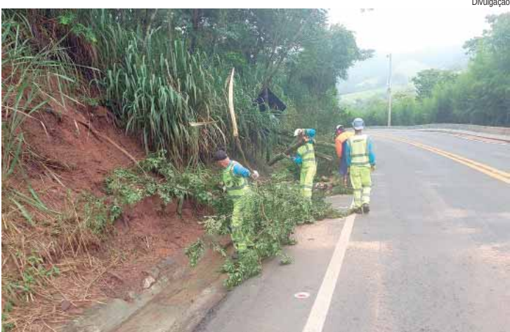
Circulação de veículos entre Torrinha e Santa Maria da Serra seguirá pelo sistema Pare e Siga em razão de serviços de manutenção
