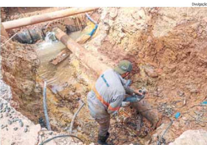
Obra na casa de bombas da Estação Elevatória Marechal vai ampliar abastecimento de água para 36 mil pessoas
