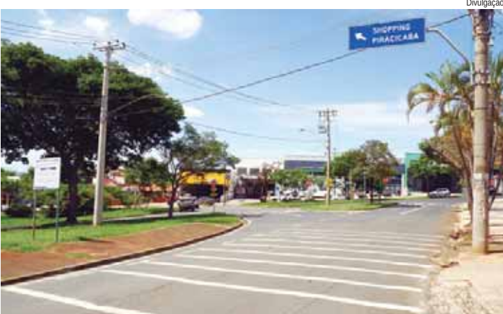
Rotatória da av. Dr. Paulo de Moraes com sinalização reforçada
