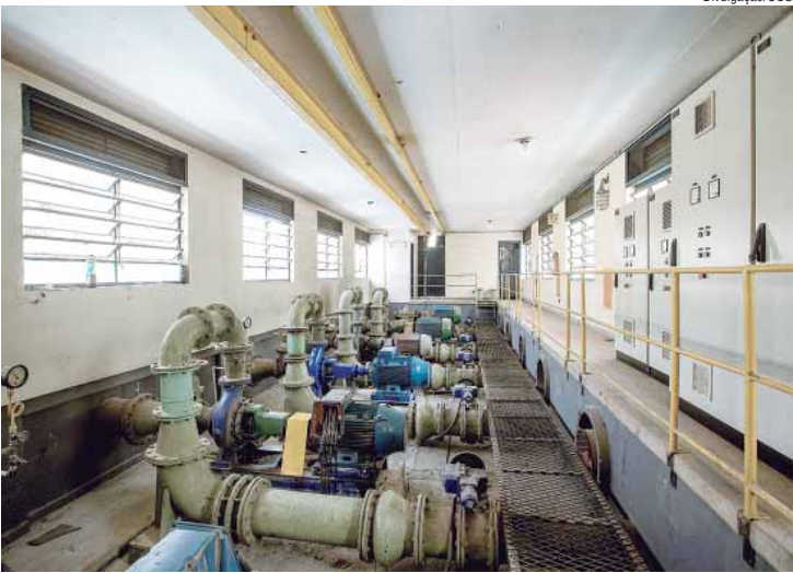
A terceira etapa de obras de ampliação e melhorias na casa de bombas do Reservatório Marechal será terça, dia 6
