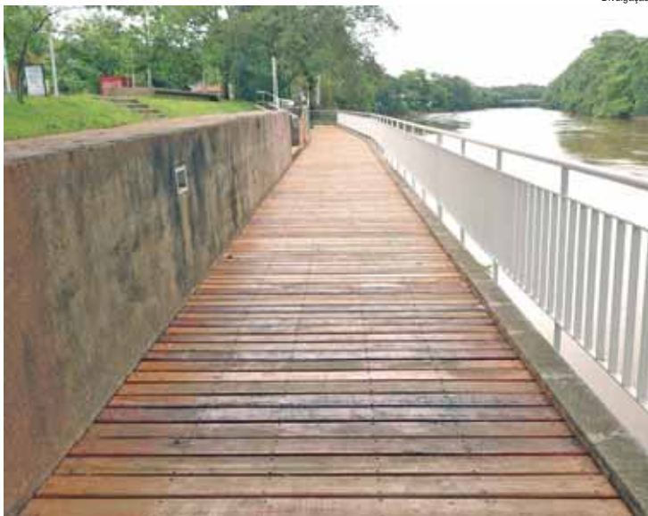
Reforma integra pacote melhorias na infraestrutura da Rua do Porto
