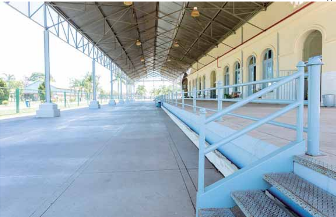
A intervenção também contemplou parte da Gare
