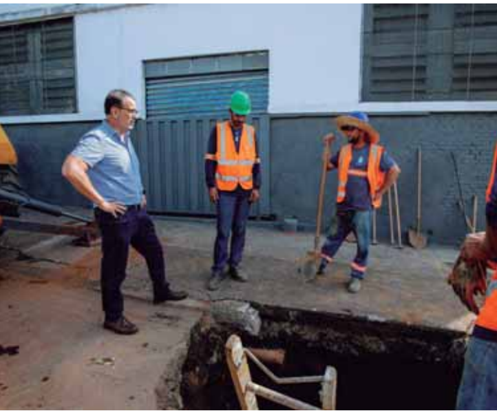
No Areão, estão sendo executadas obras de drenagem, que antecedem a pavimentação de concreto da avenida 1º de Agosto
