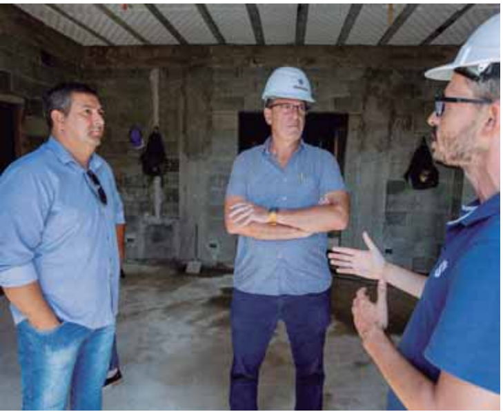
Completando o dia de visitas, o prefeito esteve nas obras de construção da nova USF do Tatuapé II
