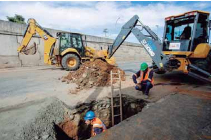
O trecho da 1º de Agosto a ser recapeado fica entre a avenida Mário Dedini até a passarela ao lado da Arcelor Mittal
