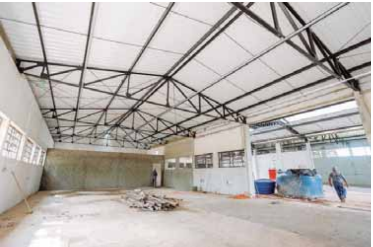
O espaço que abrigará o almoxarifado tem 1.782 metros quadrados, e receberá adequações hidráulicas e elétricas e pintura externa e interna e nova cobertura
