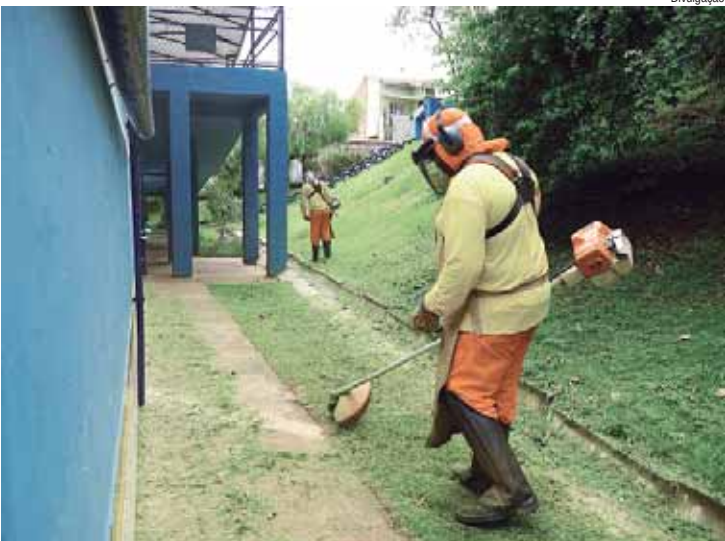
Estão sendo executados serviços de manutenção, limpeza e corte de vegetação em todas as 124 unidades da Rede Municipal de Educação
