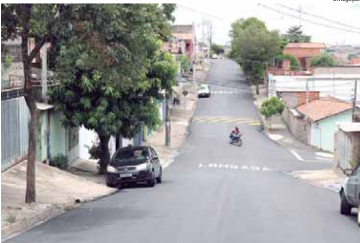
A obra contemplou instalação de galerias de águas pluviais, construção de rampas de acessibilidade e recapeamento
