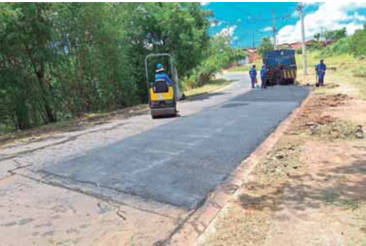
Em visita ao bairro, Paraná acompanhou o trabalho da secretaria municipal de Obras e Zeladoria, que realizou o reparo asfáltico e a operação tapa-buracos em várias ruas
