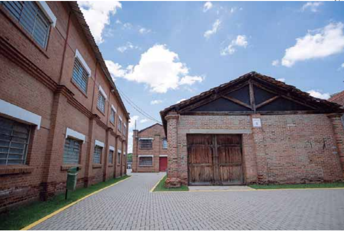
Ciclovias terá trecho dentro do Engenho Central
