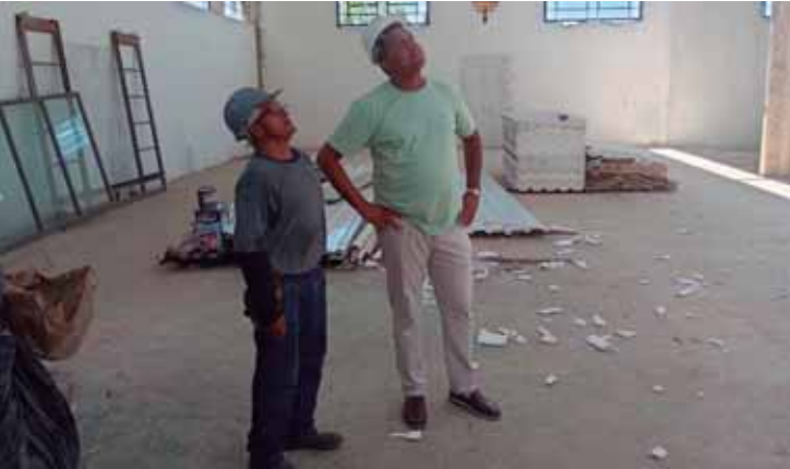
Obras no prédio que receberá as instalações da Semad, localizado na avenida Professor José Ribeiro Borges, no bairro Taquaral, devem ser concluídas em agosto
