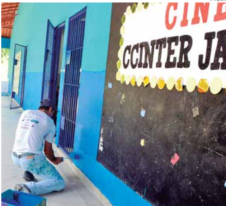
Unidade Jaraguá recebe nova pintura e serviços de reparos
