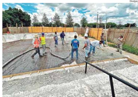
Obras de concretagem do piso da pista de skate do Cecap
