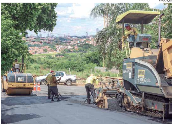
Obra já contemplou instalação de galerias de águas pluviais e construção de calçadas e rampas de acessibilidade
