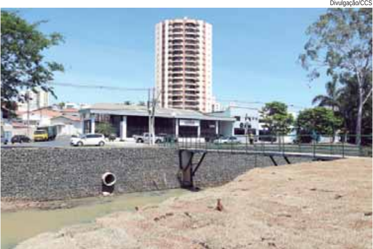
O serviço contemplou a construção do muro de gabião, com extensão de 49 metros e quatro metros de altura
