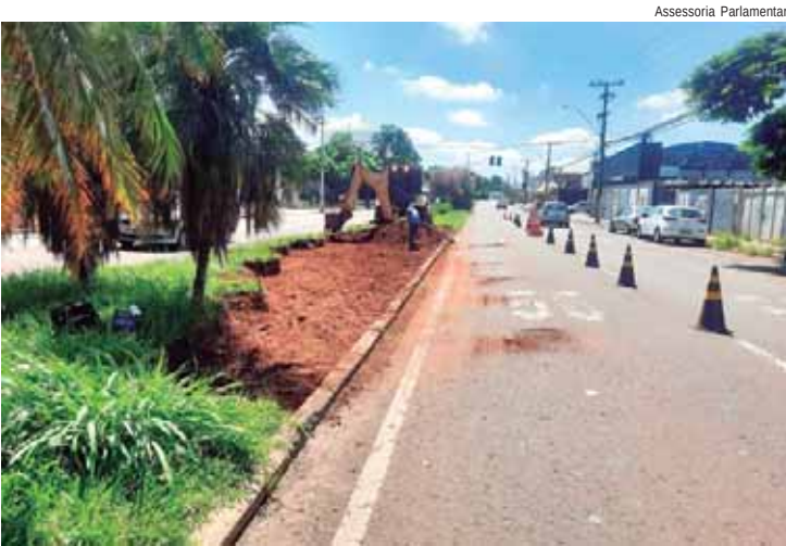
Paraná acompanhou o início das obras de abertura de via no bairro
