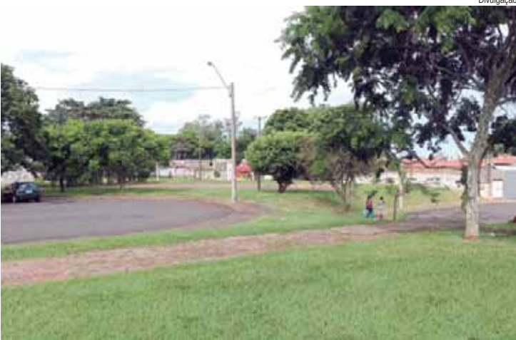
A pista terá 350 metros e será feita em concreto; obra prevê ainda rampas de acessibilidade e iluminação de LED
