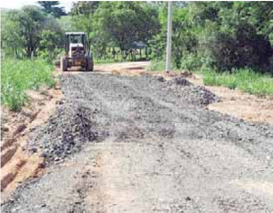
Na estrada Francisca Domingues Detoni (PIR 302) foi colocado lajão britado
