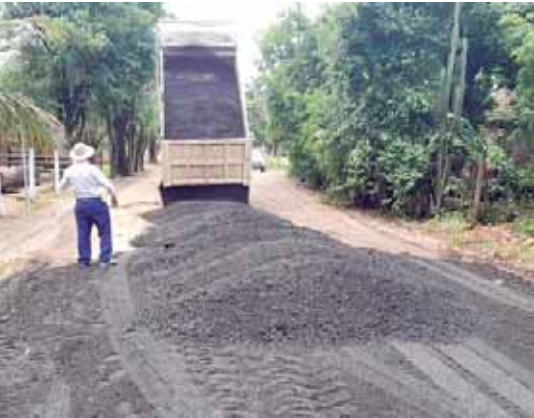
Na estrada de Godinhos, está sendo realizada a aplicação pontual de fresa
