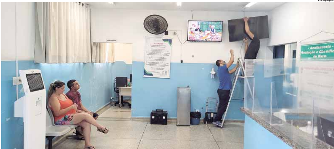
Equipamentos instalados por toda unidade permitem que o paciente acompanhe, em tempo real, seu atendimento dentro da COT
