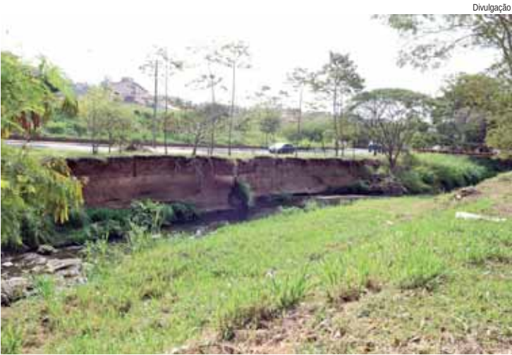
O objetivo é evitar que a erosão aumente e prejudique a via, além de melhorar a passagem do ribeirão
