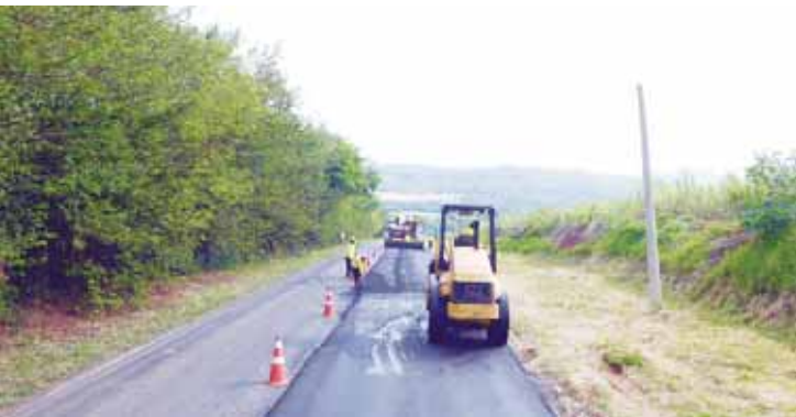
O acesso é principalmente utilizado por veículos pesados e, por isso, é necessária a compactação do solo que garante maior durabilidade
