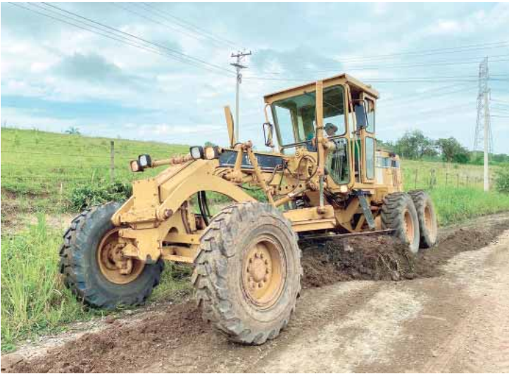
Manutenção com motoniveladora na estrada José Saul Chinelato
