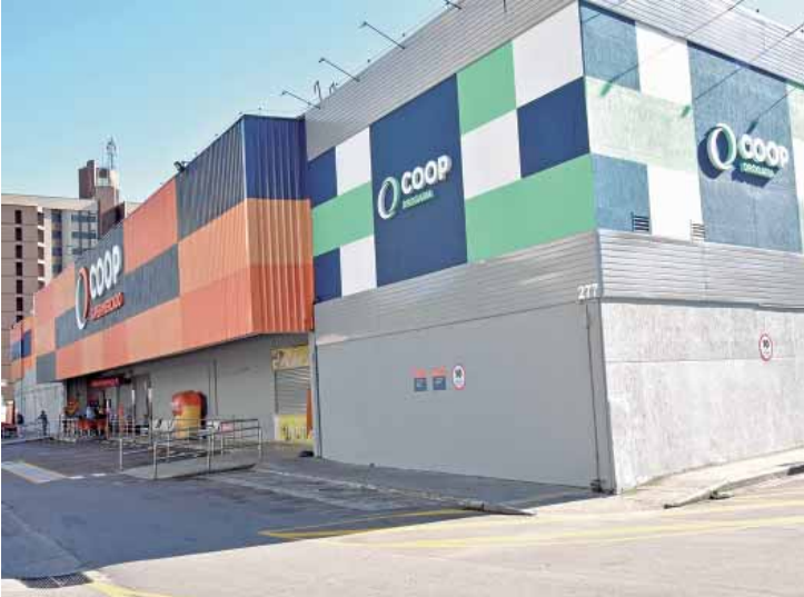
Fachada de um dos prédios da Coop, que tem loja em Piracicaba
