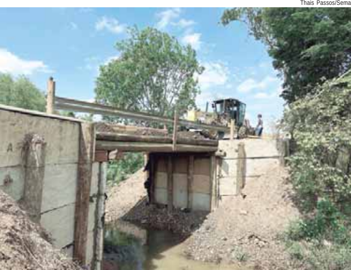
Ponte reconstruída tem 7 metros de extensão por 4 de largura
