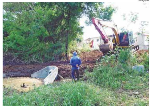
Obras iniciaram com a execução do sistema de drenagem, com instalação de tubulação e muro de alvenaria
