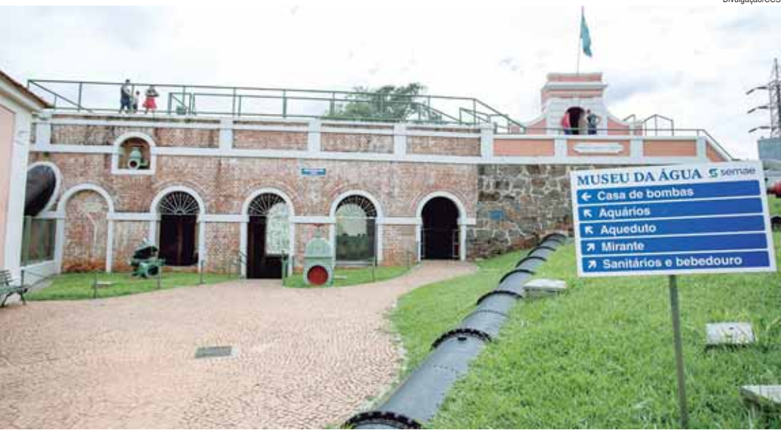
Museu da Água fica hoje: manutenção da rede elétrica
