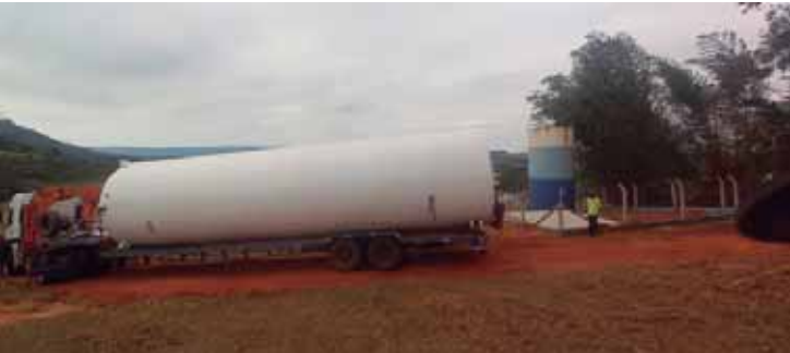
Reservatório de água do Jardim Botânico 2
