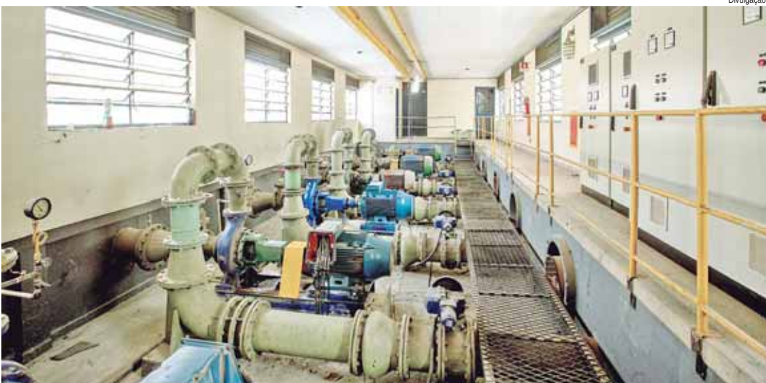
Serviços vão ampliar a segurança com relação ao bombeamento e ao abastecimento de água
