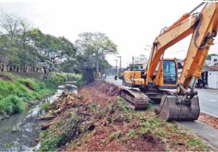
Equipe faz limpeza da margem para construção de muro de gabião
