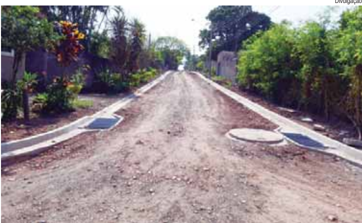
Na rua Luis Bergamasco já foi executada adequação no sistema de drenagem; próxima etapa será pavimentação em toda extensão da via
