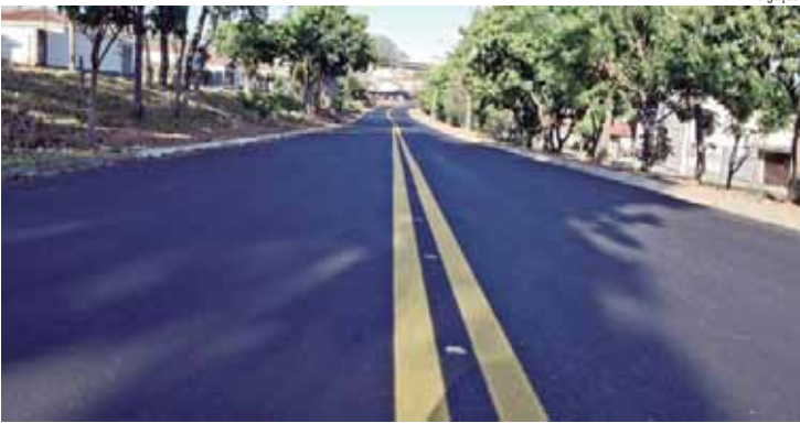
Prefeitura concluiu a pavimentação na Cristóvão Colombo, no Algodão
