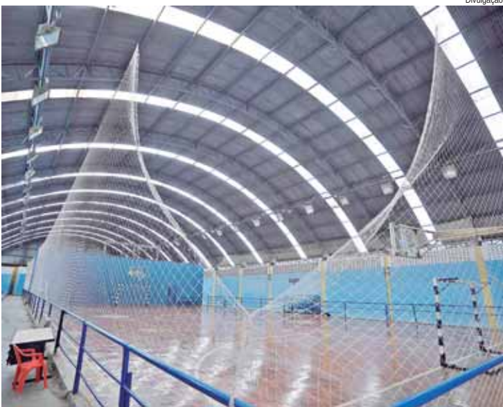
As reformas contemplam a troca das telhas translúcidas e algumas telhas metálicas, conforme a necessidade
