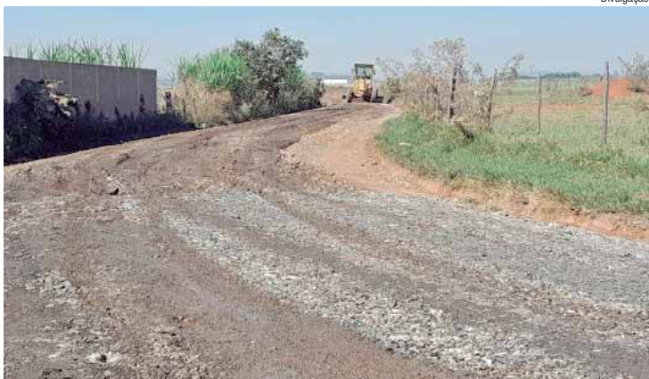
Os serviços na estrada Duzentos Réis foram concluídos
