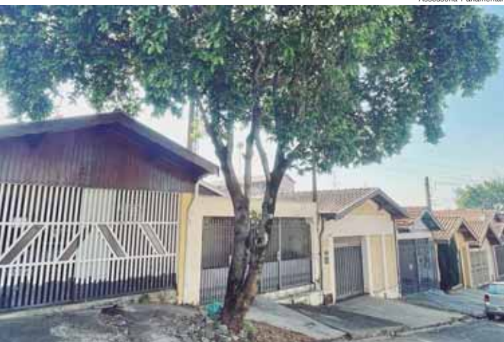
Removida por equipes da Simap e do Sema, as raízes danificavam a calçada e a residência. Anilton Rissato, autor de indicação sobre o tema, verificou os serviços
